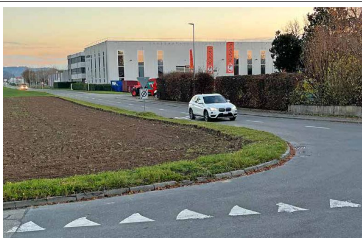
Den Auftrag via Antrag aus der Bevölkerung erhalten: Der Wikoner Gemeinderat muss eine Strategie erarbeiten, die zu einer gerechteren Strassenfinanzierung in den Arbeitsgebieten beitragen soll. Foto: Stefan Bossart
