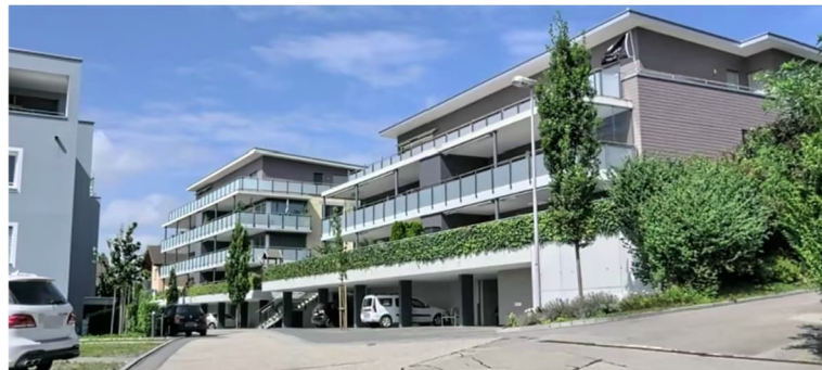
Abb. 66: Grundhofstrasse Nord, Blick von Osten
